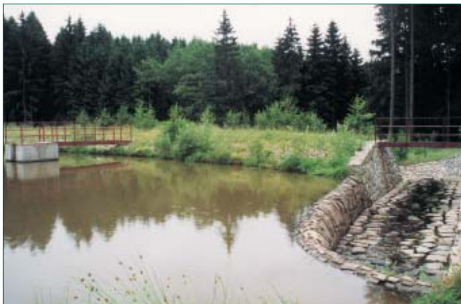
Retenční nádrž na LS Třebíč
