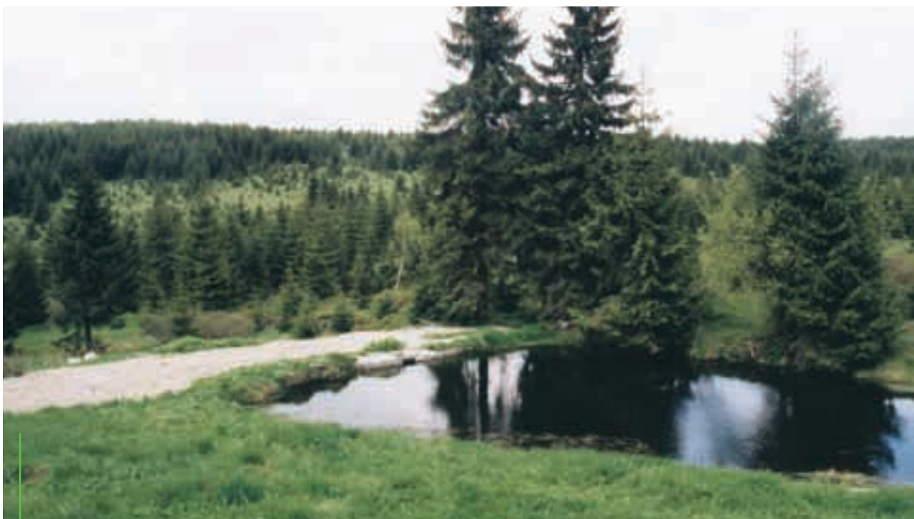
Retenční nádržka pro zpomalení odtoku vody; Jizerské hory
