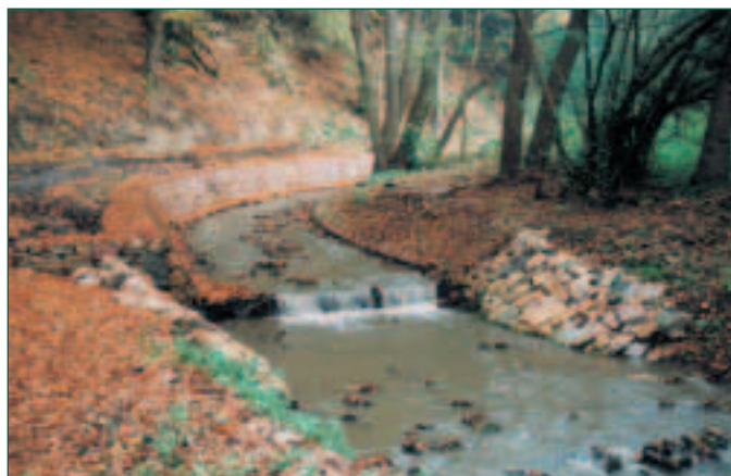
Podélné opevnění břehu koryta potoka Tresného, který teče souběžně s odvozní cestou
