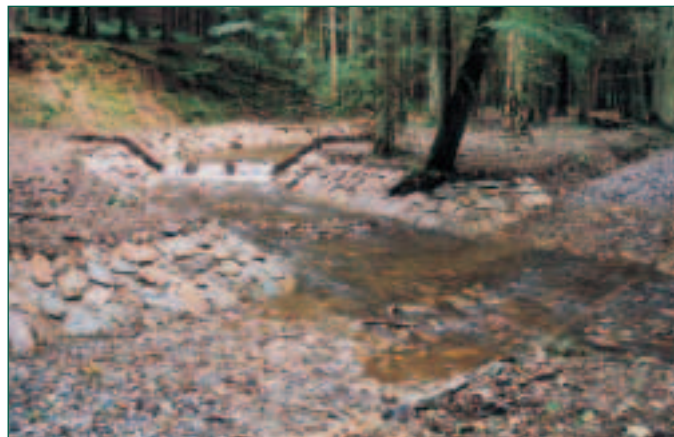
Úprava koryta potoka Tresný (řešení brodu) poblíž obce Koroužné, okr. Žďár n. S., OST Brno
