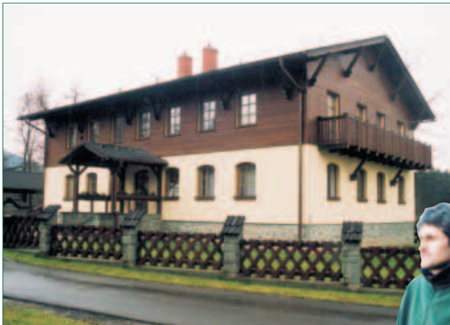
Stavba nové budovy lesní správy vychází z tradic beskydské architektury
