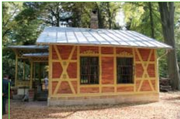
Zrekonstruovaný altán v arboretu Bukovina
