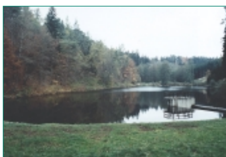
Obnovený rybník Hamr nad obcí Hořehledy
