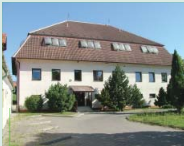
Budova LS Buchlovce
