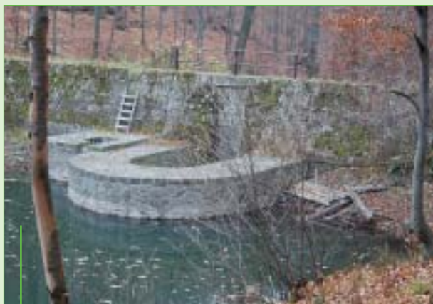
Přehrážka na plavení dřeva
