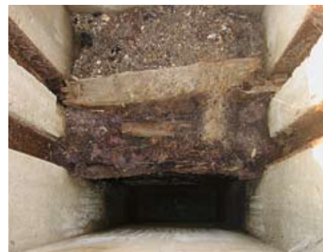
Nádře Zbrašín v Selmicích na Lounsku (zanesení odpadního potrubí)
