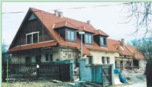
2. Hájenka Čirhan v rekonstrukci rok 2003
