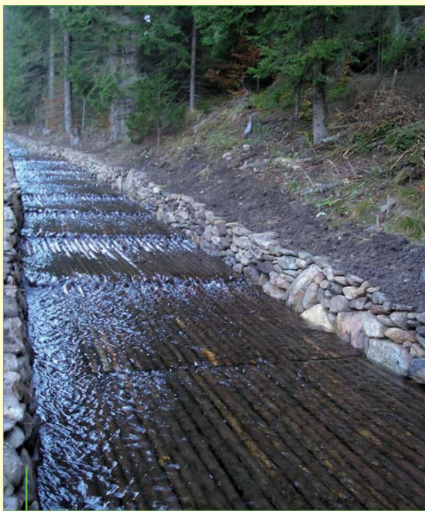
Kaplický potok, úprava plavení dříví pod národní přírodní rezervací Boubínský prales, oprava provedena v roce 2005
