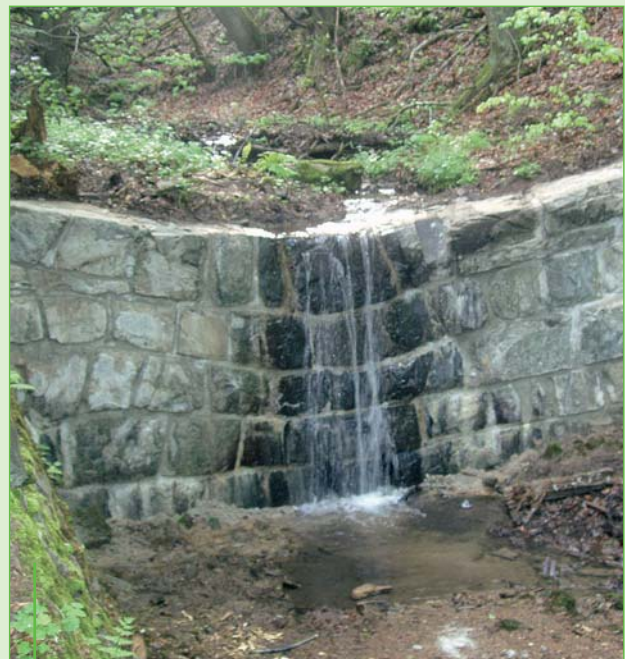
Přítok Třeblové – Třeblová je přítok Vltavy pod Neveklovem v okrese Benešov. Oprava starých objektů hrzení bystřin.
