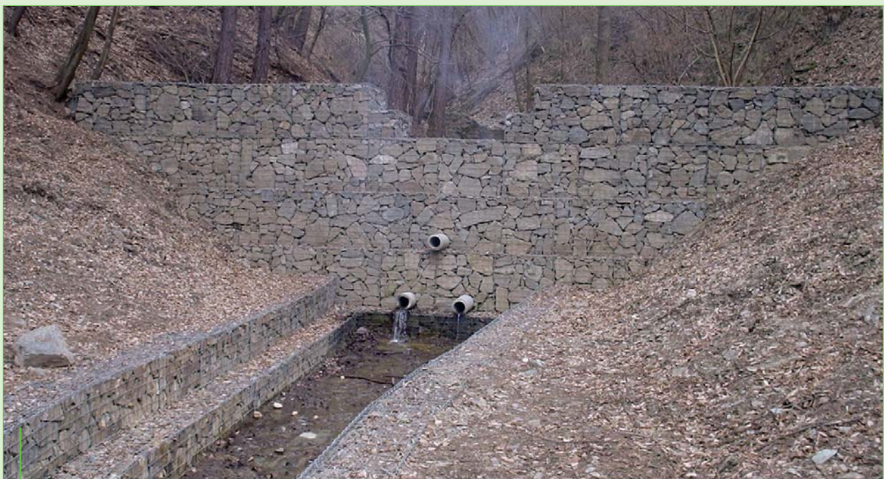
Strž Javorka – přehrážka postavená v roce 2003 z drátokamene (gabionů). Nad přehrážkou je vidět další přehrážka z kamenného zdiva. Její retenční prostor je již zcela zanesen splaveninami.
