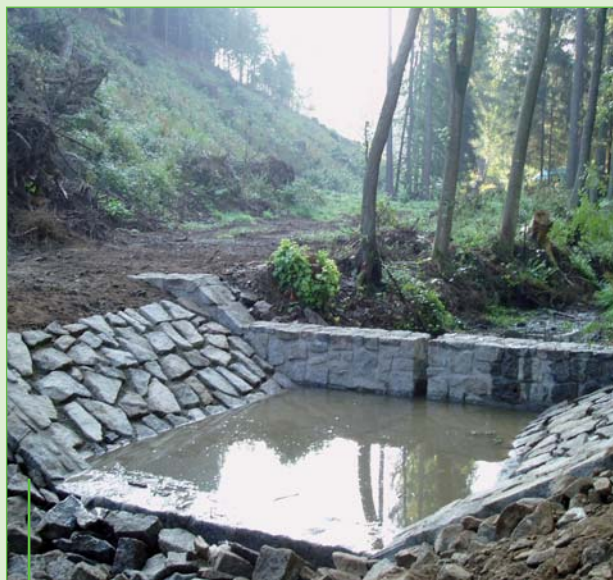
Úprava Vodslivského potoka
