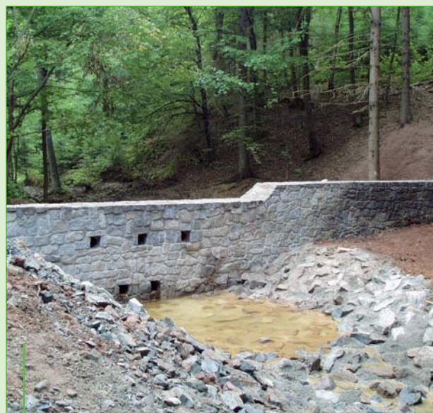
Tok Dílna – přehrážka vybudována po povodni 2002
