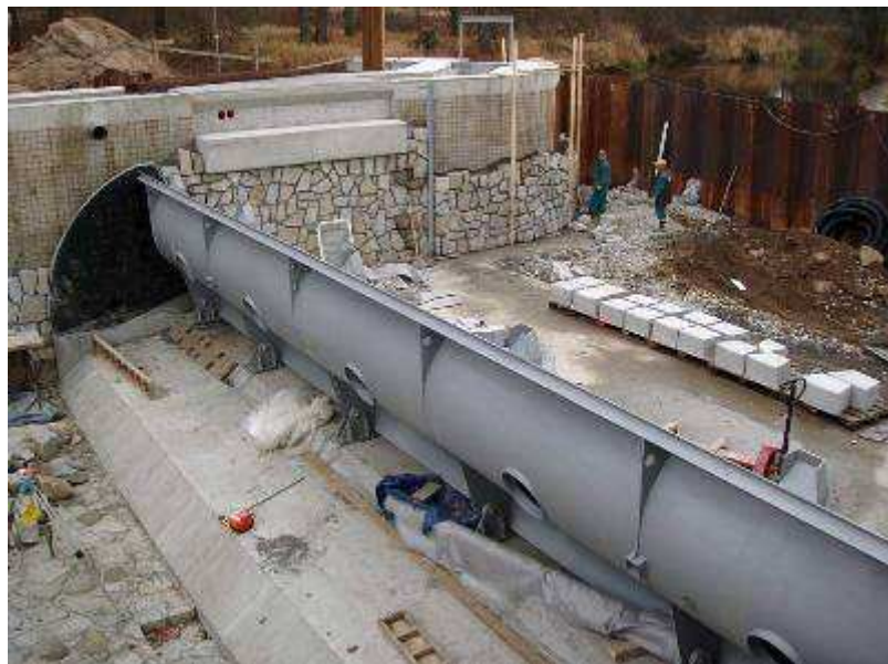
Povodí Vltavy provádí rekonstrukci rozdělovacího objektu Novořecké splavy.
