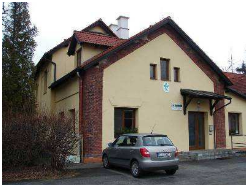
Třeboň - Holičky, budova lesní správy
