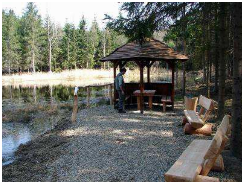
Opravená retenční nádrž u Týna nad Vltavou
