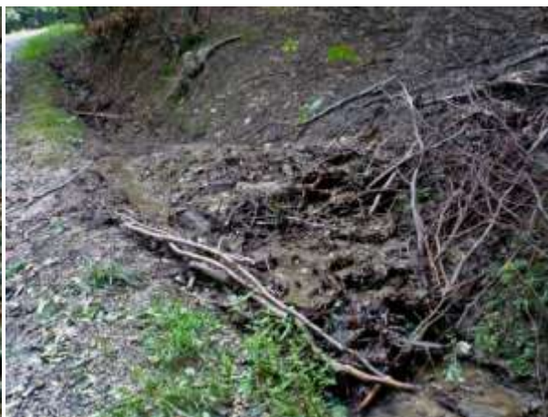
zanesený příkop LC
