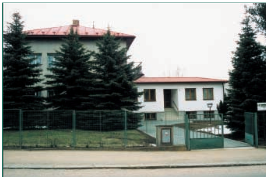
Budova LS Nové Město n. M.
