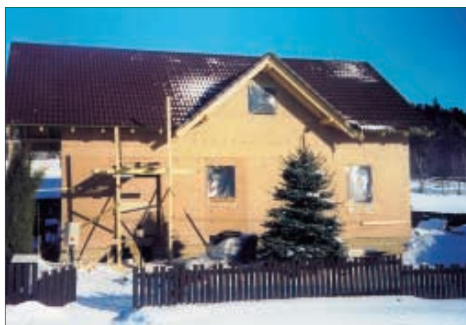
Sendvičová konstrukce budovy revíru Benetice na LS Třebíč
