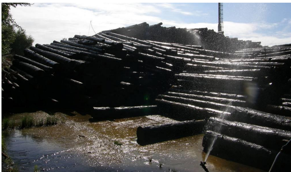
Obrázek č. 12: Stav odvodnění plochy skladu.
