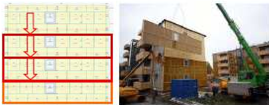
Obr. 1 Instalace přídatných vysoce prefabrikovaných fasádních dílců
