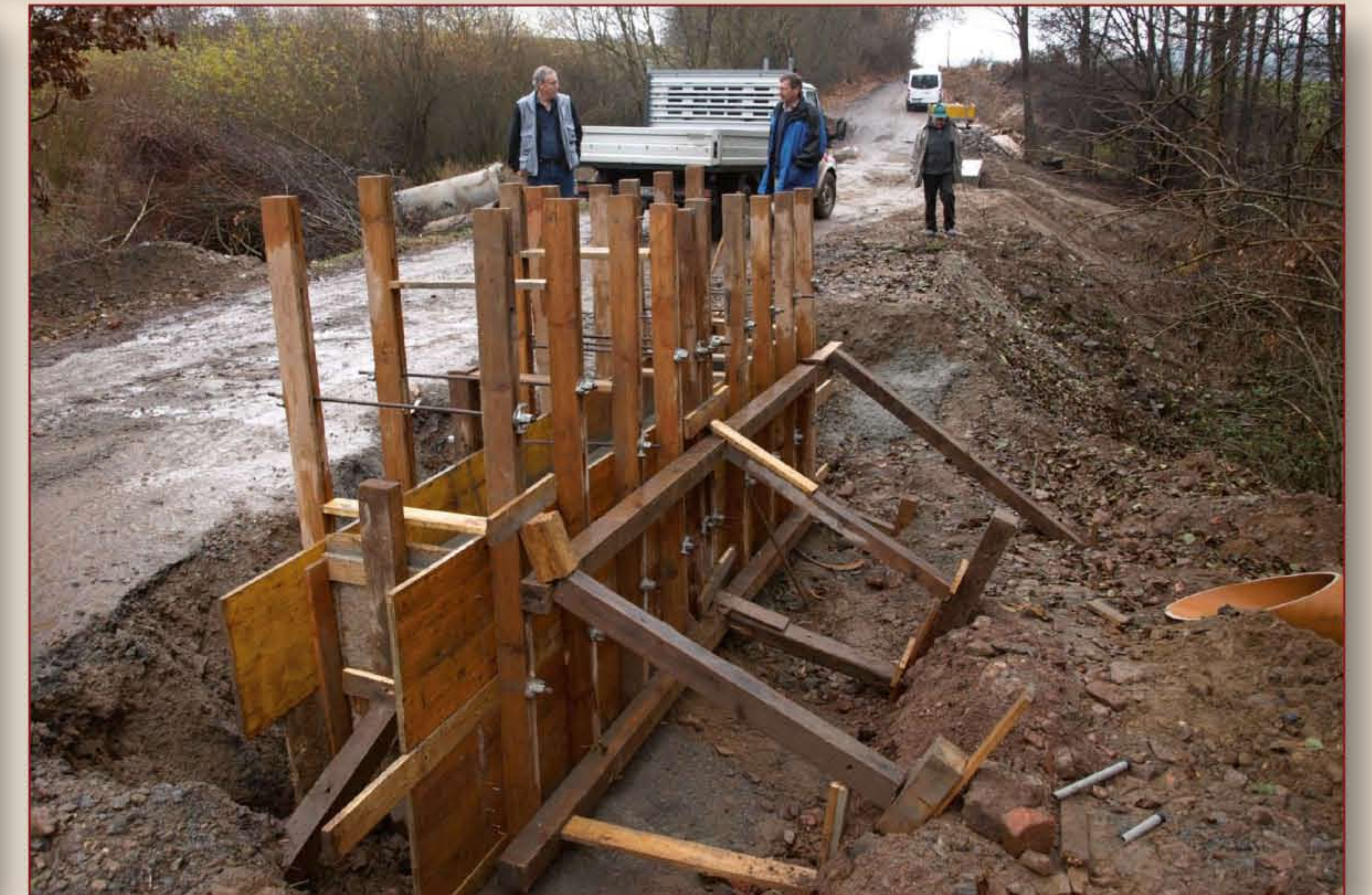
Betonování opěrné zidky okolo propusti - 12. listopadu 2008
