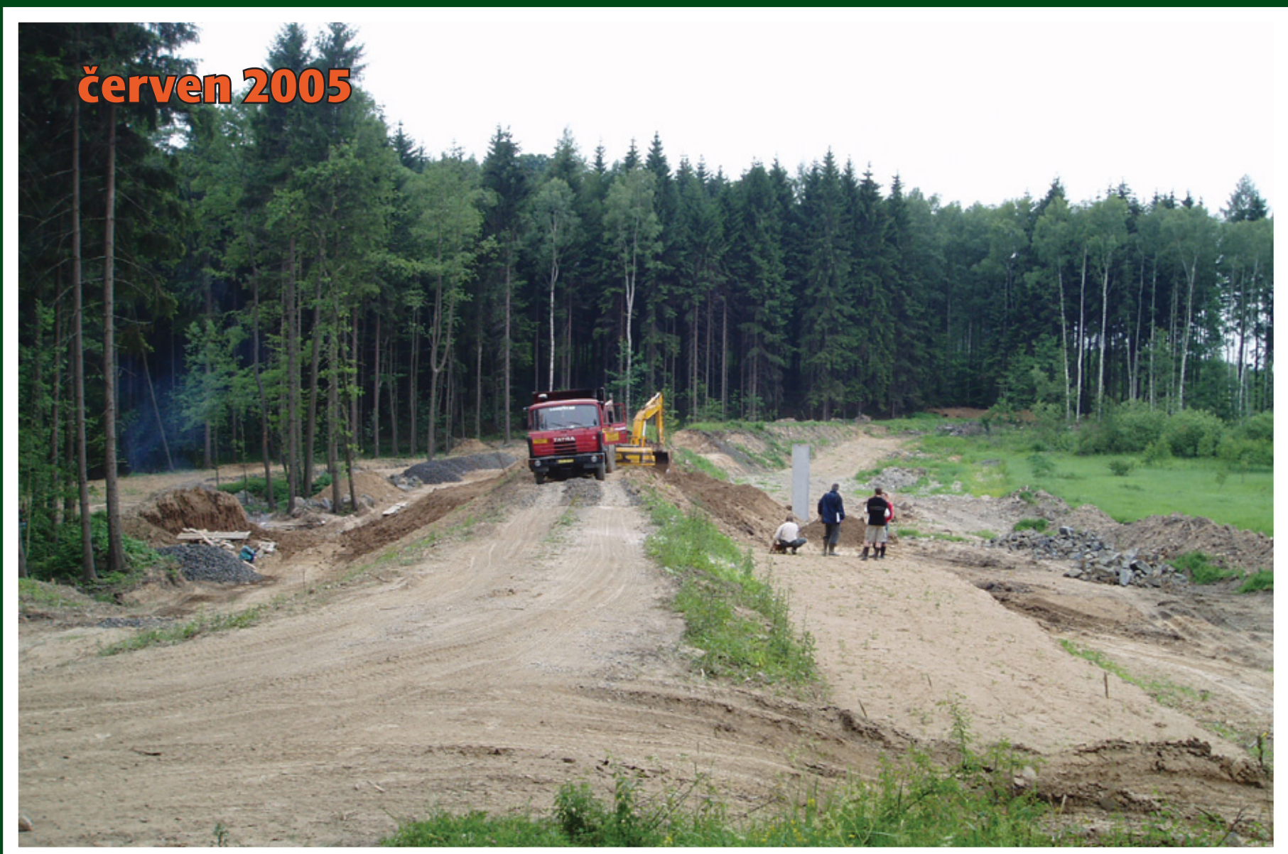
Výstavba spodní výpustě
