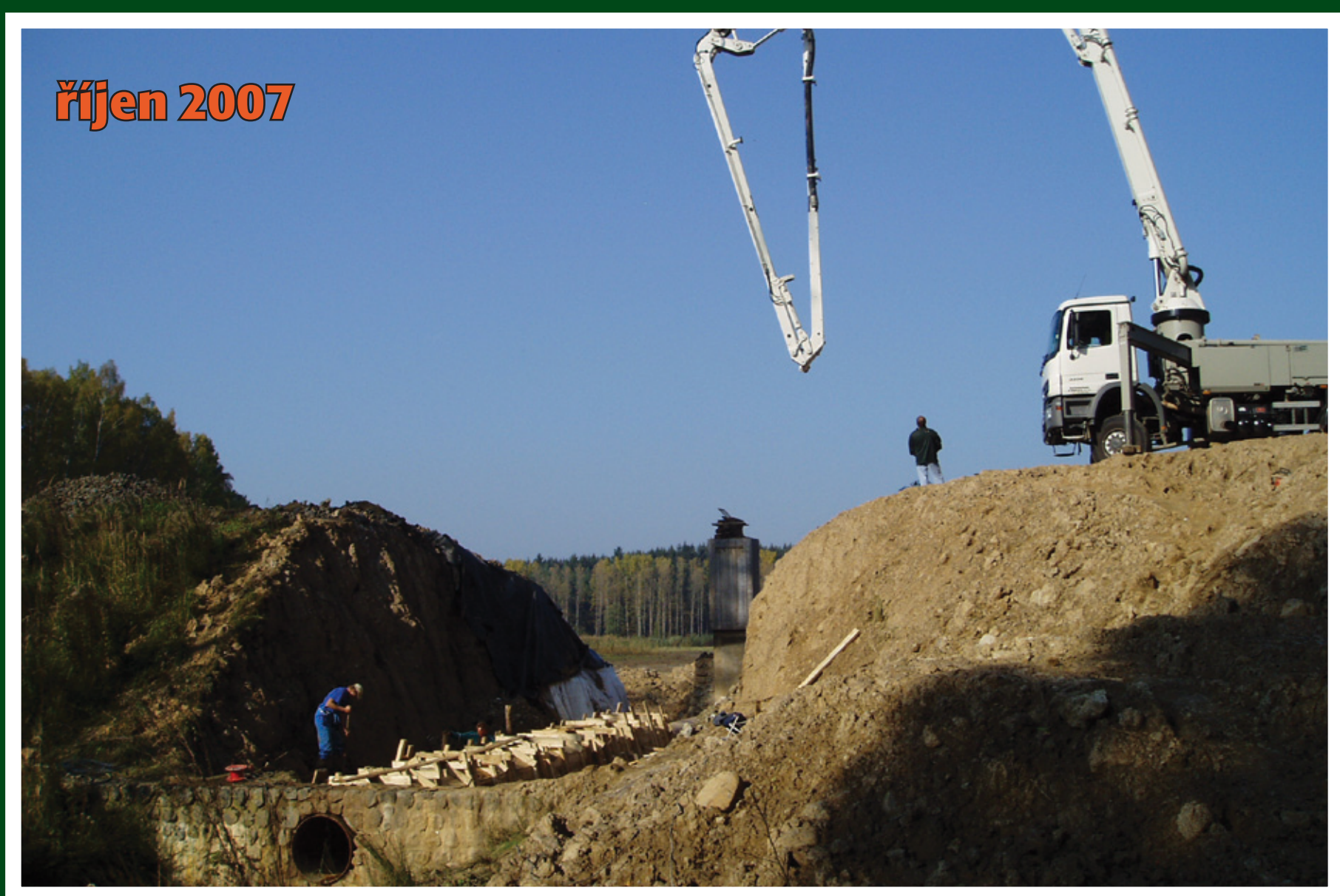
Betonování výpusti Velkého rybníka
