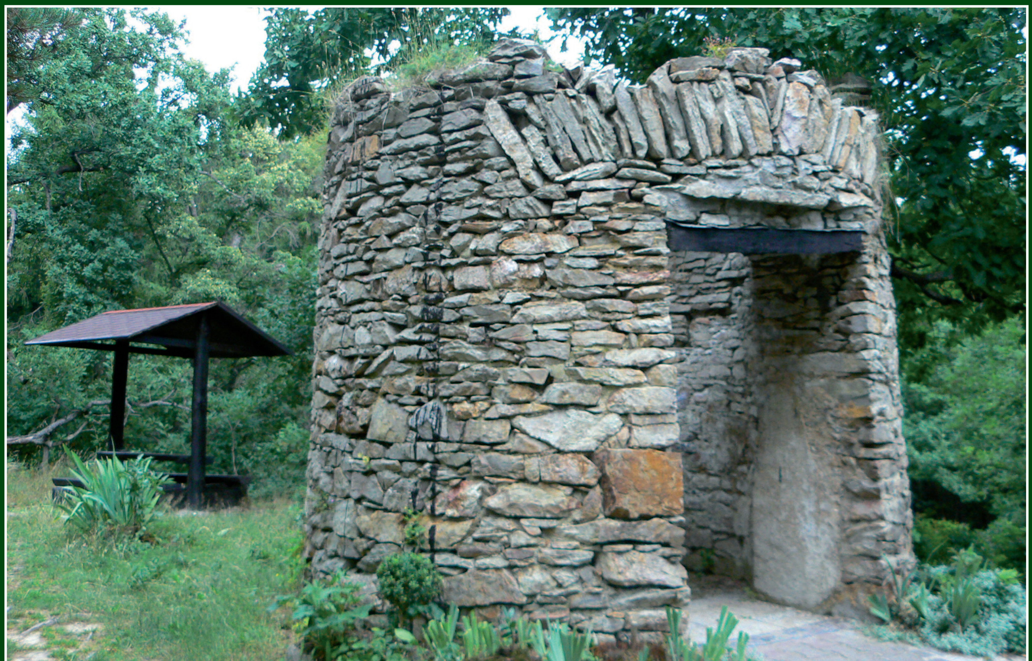
Zbytky bývalé protipožární strážní věže na vrcholu Chlum; foto Milan Morch
