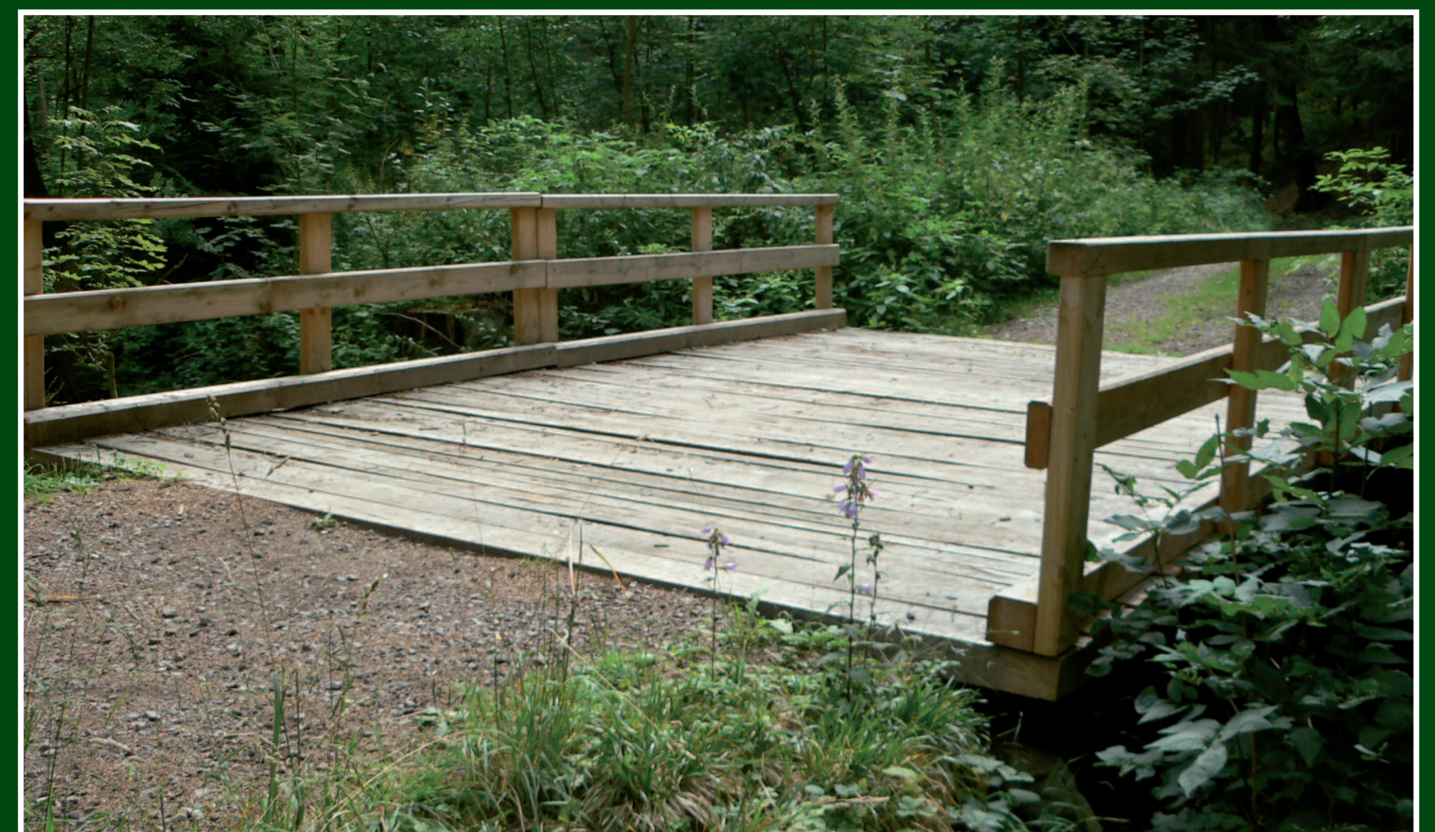
Dřevěný most; foto Milan Morch
