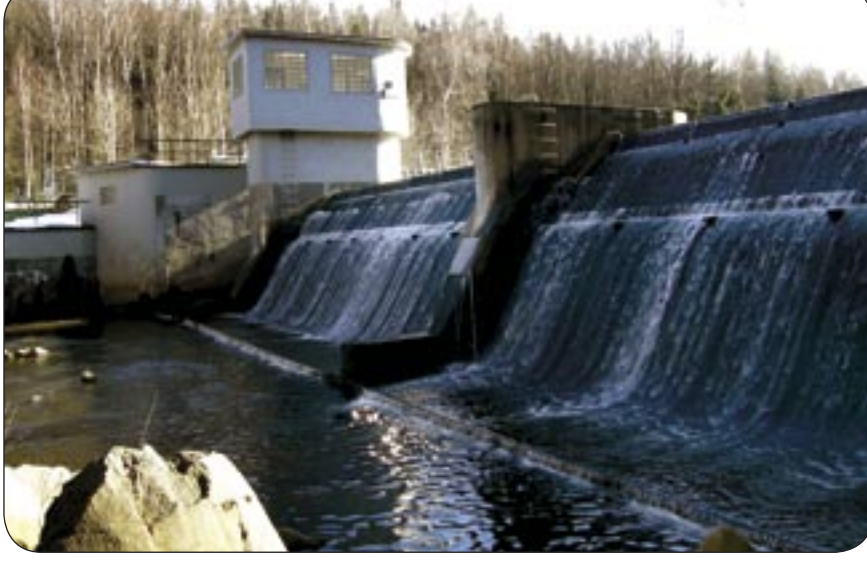
5f – Jez s pohyblivou korunou Wehranlage mit beweglicher Krone
